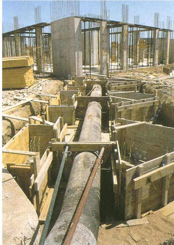
Instalación de tubo para una red interior (colocación en obra).
