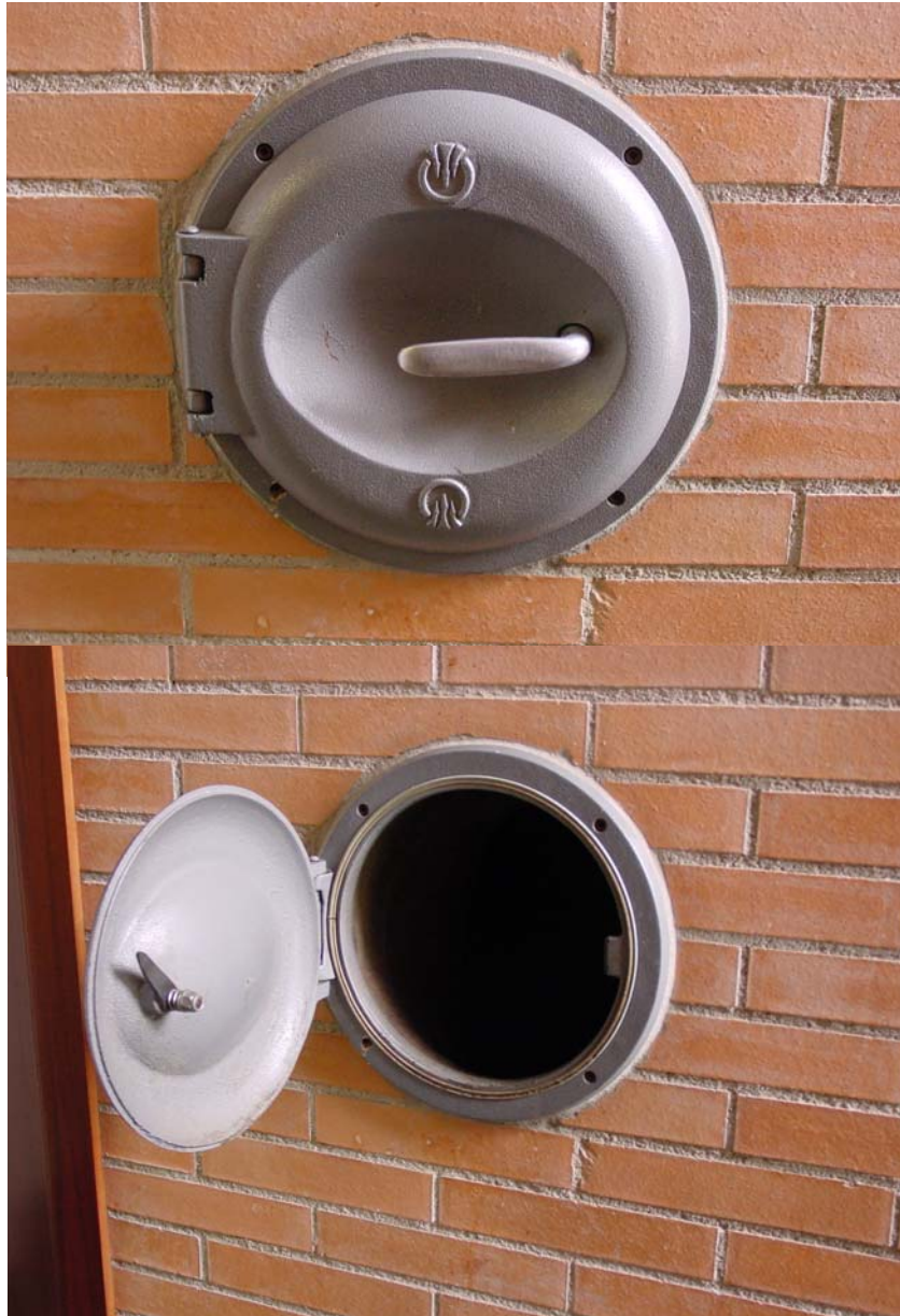
Compuerta tipo doméstica, con boca de apertura de \varnothing = 30 cm.
