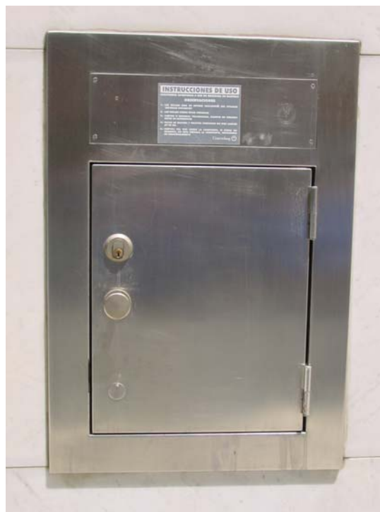
Compuerta comercial tipo, de dimensiones 40*60, con llave y sensor de puerta abierta.
